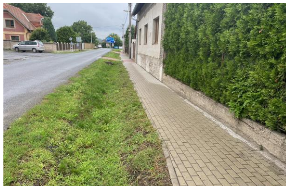
Obr.: Chodník u hlavní silnice, na který má obec záměr navázat k Zahradní ulici a podél Korycanské
