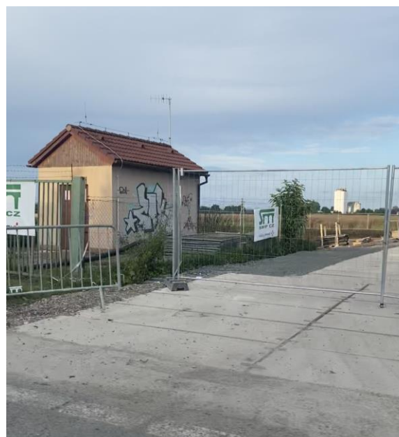
Obr.: Výstavba vodojemu u kruhového objezdu Bašť/Líbeznice/Měšice
